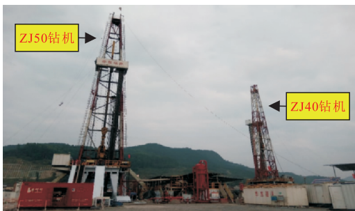
图6 东胜区块胜页2平台大小钻机工厂化钻井现场
